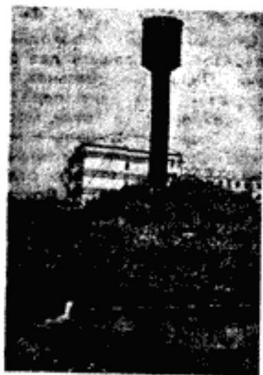
Чульма. На строительстве МЖК. Самоизлив скважины в озеро Иткульское.
